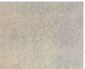
Condition A Blasted to Sa 2,5
