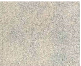
Condition B Blasted to Sa 2,5
