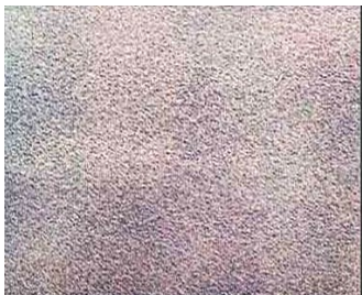
Condition C Blasted to Sa 2
