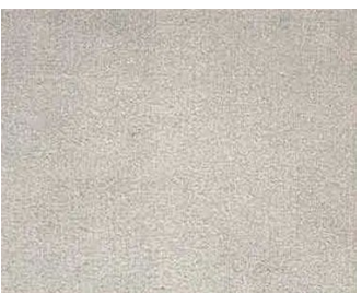
Condition B Blasted to Sa 3
