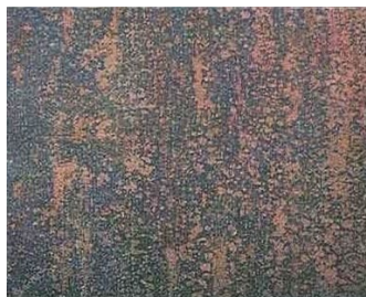
Condition B Blasted to Sa 1
