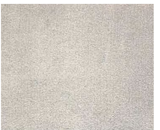
Condition C Blasted to Sa 3
